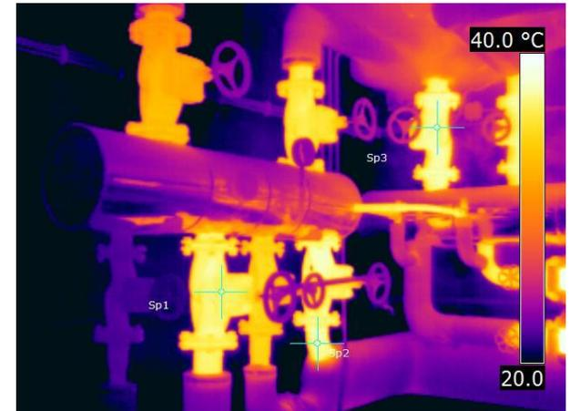
1 m nicht isolierte Heizungsleitung entspricht ca. **10 - 15 l Heizöl/a**
